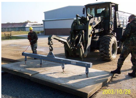
2. ábra Előre gyártott pályaelem beemelése [17]
