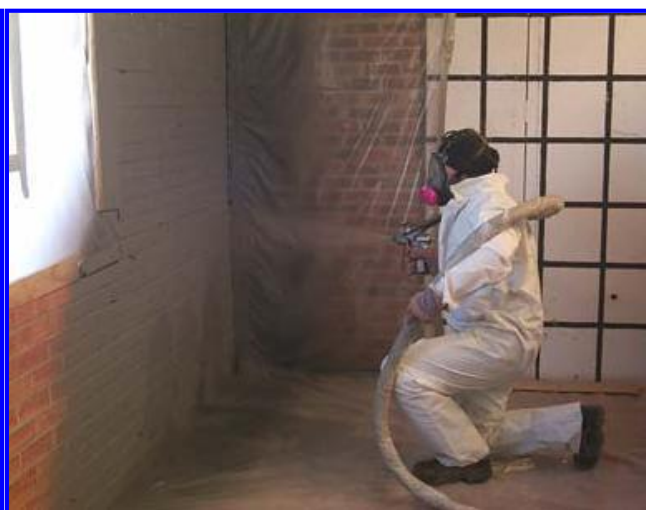
17. ábra Polimer réteg felhordása a falazatra[17]
