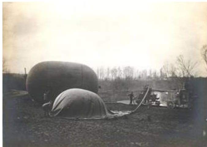
29. ábra Gázgyártás tábori viszonyok között [3]
