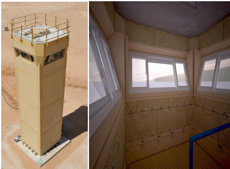
9. ábra Blokkokból épített őrtorony [5]
