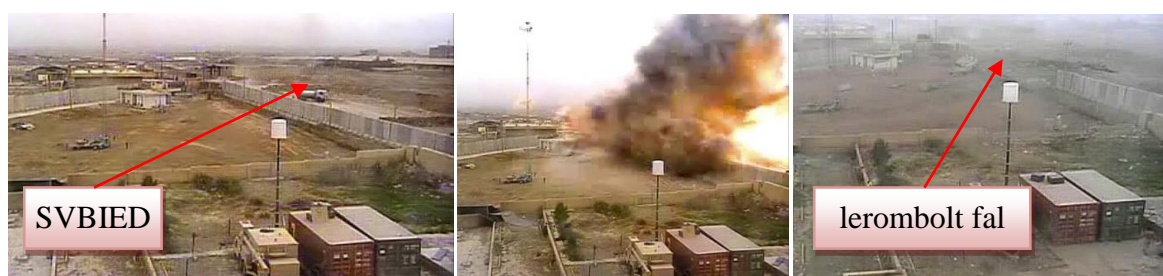
25.7 ábra T-Wall típusú vasbeton védőfal tönkremenetele - Irak
