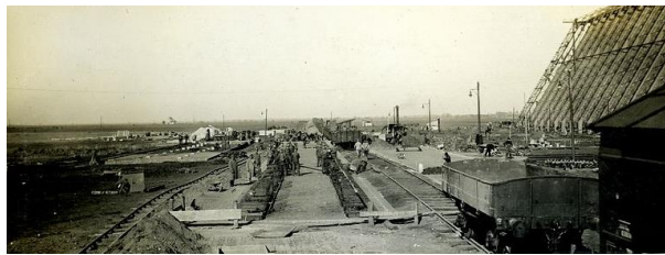
2. ábra. Vasúti rakodó a keskeny nyomtávú szárnyvonallal
