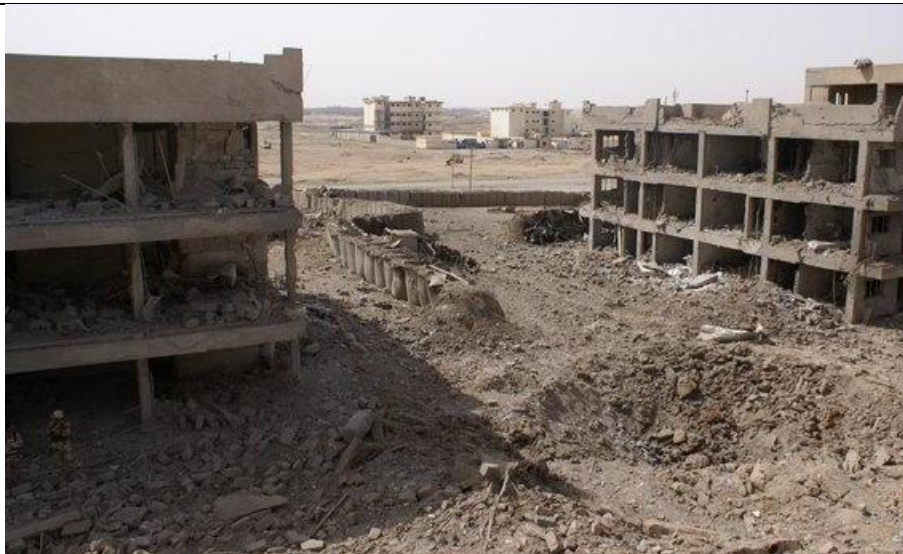
27. ábra Robbantás után állva maradt vasbeton épületek - Irak
