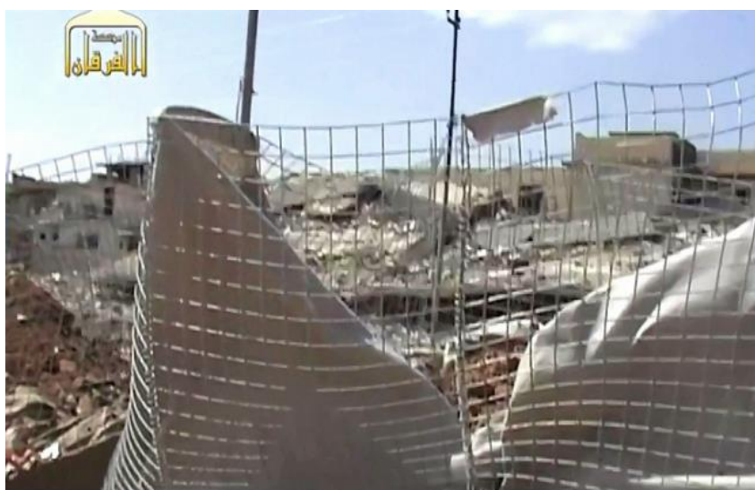
26. ábra Lerombolt HESCO bástya robbantás után - Irak
