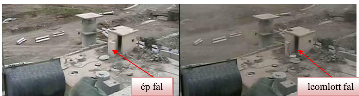
28. ábra Támaszponti épület előfalának leomlása a robbanás következtében - Irak
