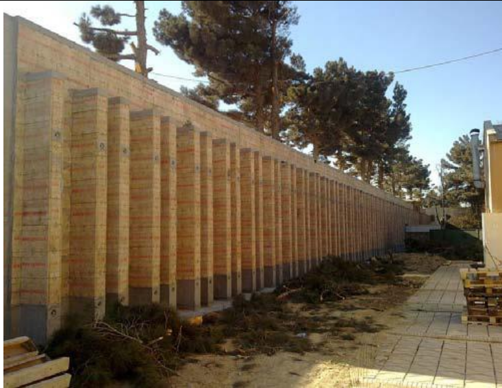
7. ábra Blokkos kerítésszerkezet [5]
