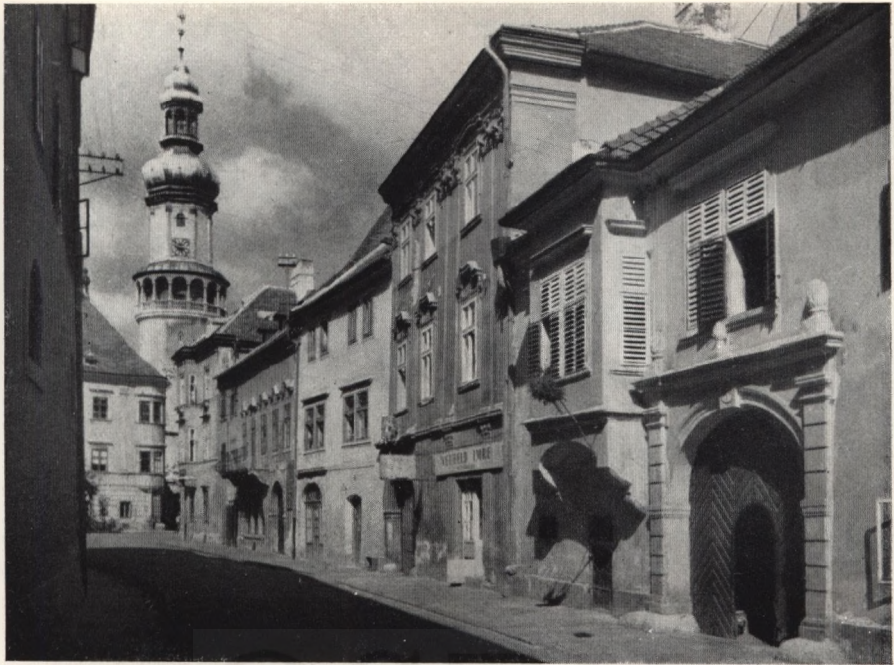
Gasse in der inneren Stadt mit Stadtturm
