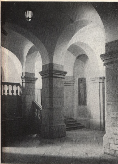
Unterbau der Kathedrale
