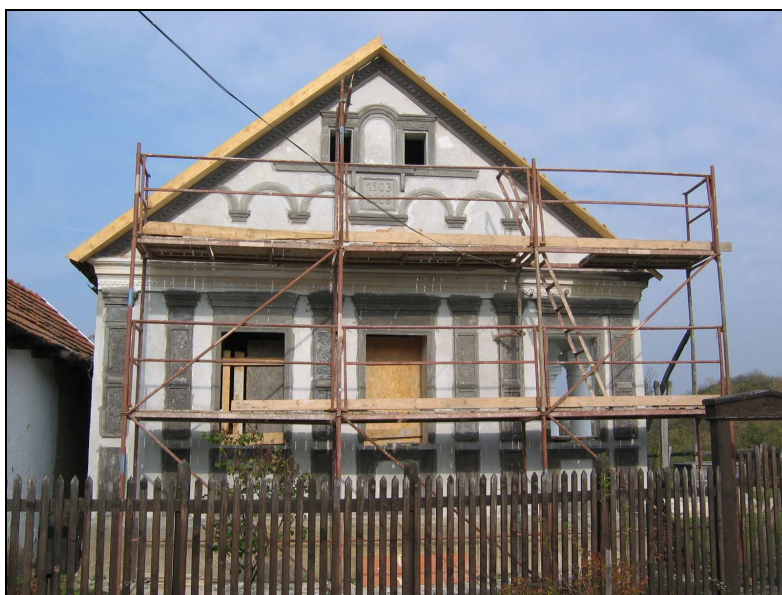
A homlokzat-rekonstrukció folyamata
