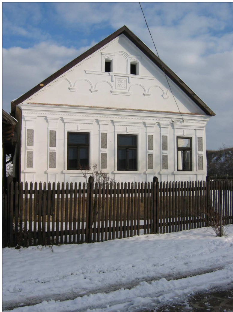
A felújított homlokzat
