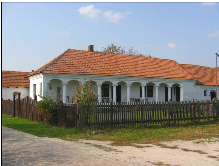
A Vadászy ház homlokzata a rekonstrukció előtt.
