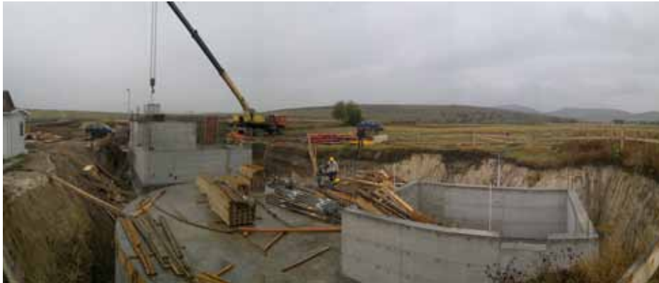
A víztisztító állomás építése Csíkmadaras határában
