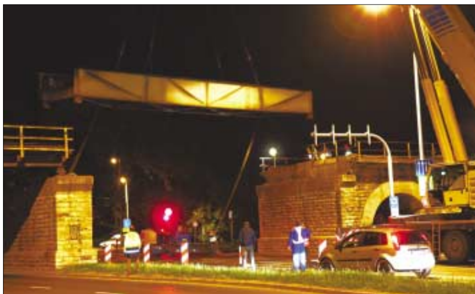
A Szentendrei úti felüljáró acélhídjának leemelése
