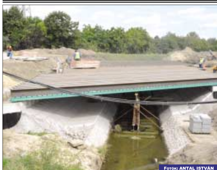
Készül az Aranyptak feletti híd az Óbuda MÁV állomásnál
