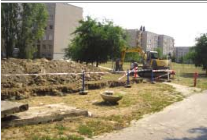
Távírási vezeték rekonstrukciós munkálatait végzik a Főtáv Zrt. megrendelésére Kaszásdűlőn. Felvételünk a Huszti út 37. szám előtt készült
