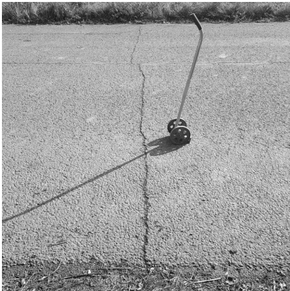
2. ábra: Az úthibák szemrevételezéssel történő rögzítése.
