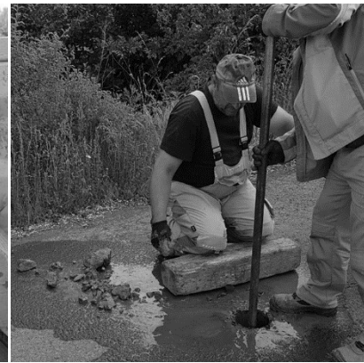
c) makadám alapréteg áttörése
