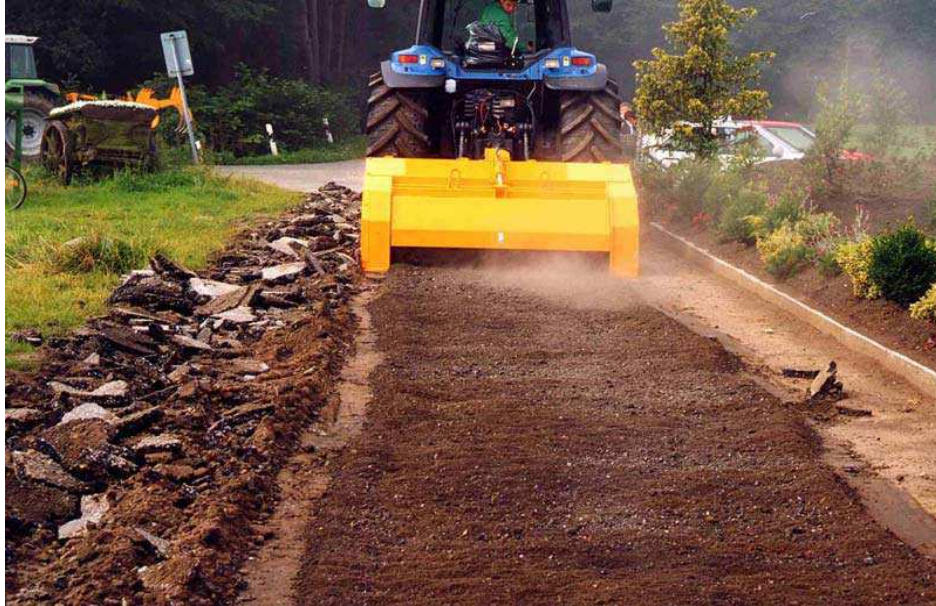
6. kép: Burkolat törése vontatott mobil törőgéppel
