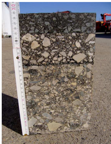
7. kép: Hideg remixszel épült pályaszerkezetből származó fűrt minta (Forrás: Thomas Krause: Kaltrecycling: Erneuerung im Straßenoberbau, 2010)
