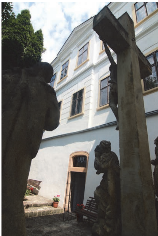
Veszprém, Boldog Gizella Főegyházmegyei Gyűjtemény. A Tejfalussy-ház kert felőli homlokzata. Fotó: Nagy Lajos
