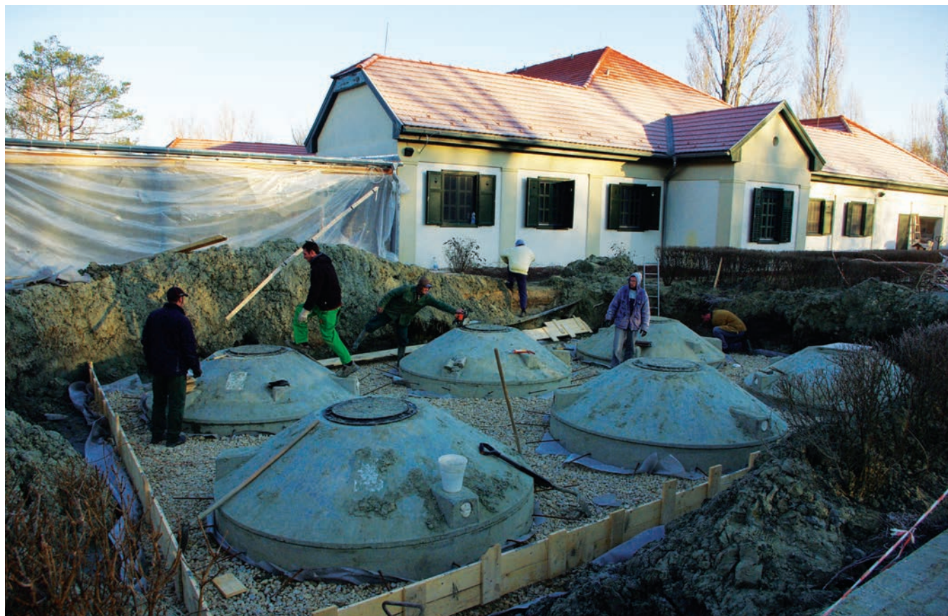
2011 márciusában megkezdődött az esővíztárolók beépítése.
