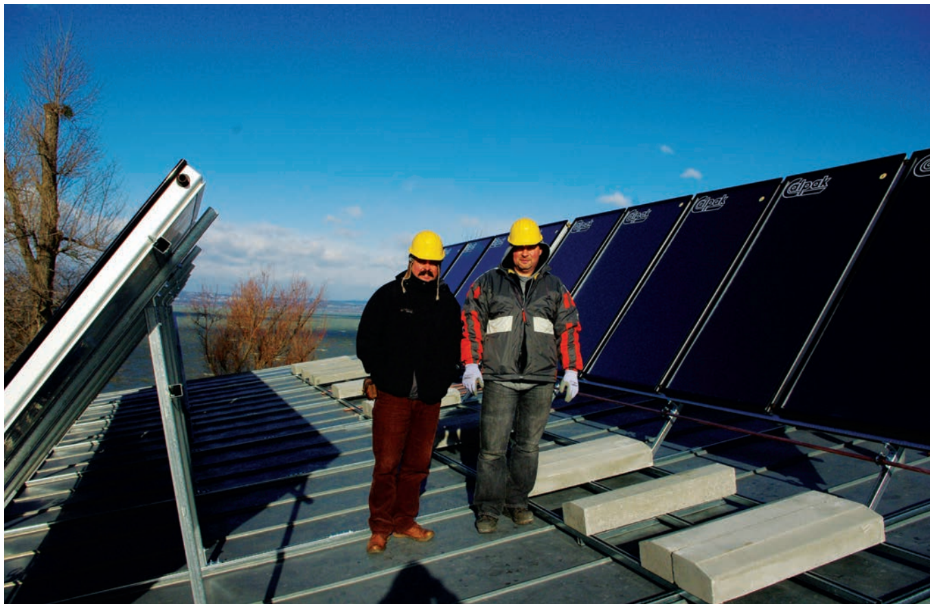
Az első nagy eredmény: felszerelték a napkollektorokat. Végh Szabolcs és a kivitelező 2010 decemberében.
