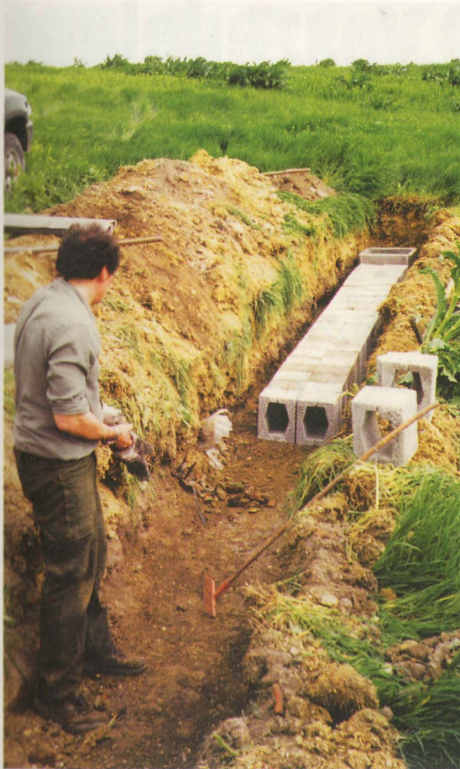
Az árok kiásását követően ágaztatják el a csatornákat
