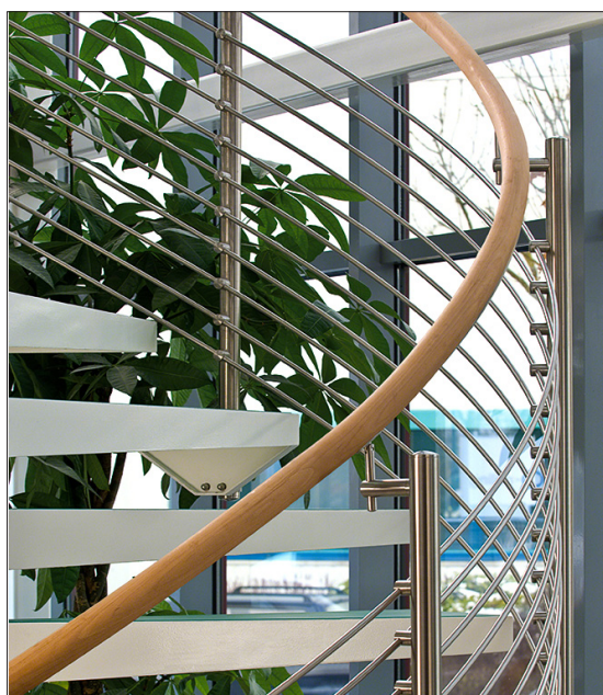
6. ábra Fa korlát tömörített bükkfából (forrás: Q-railing 2015)
