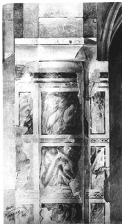
FALFESTÉS A PÉCSI SZÉKESEGYHÁZ KÖZÉPHAJÓJA ÉS ÉNEKKARZATA KÖZÖTT SZABADON ÁLLÓ PILLÉRNEK A SZÉKESEGYHÁZ NYUGATI HOMLOKZATA FELÉ ESŐ OLDALÁN. XV. sz. (?)
