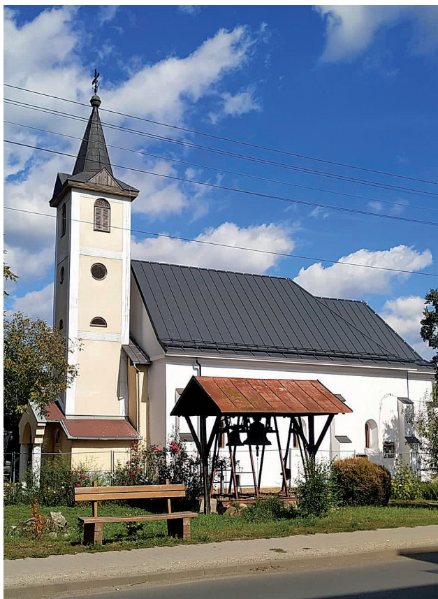
Befejeződött a Nagykovácsi Görögkatolikus Templom felújítása. (További részletek a lap következő számában)
