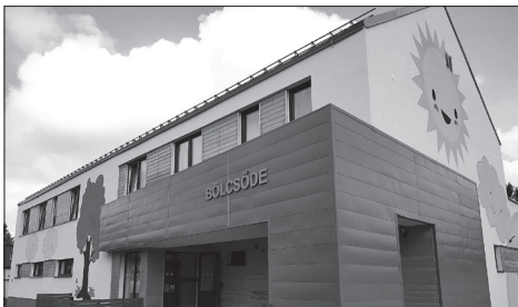
A bölcsőde épülete nem csak látványos, hanem korszerű és energiatakarékos
