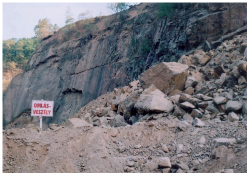
16. ábra Bányafal omlás a 177 méteres szint (Bf.) északnyugati falszakaszán Fig. 16. Pit wall collapse at the North-West section of the 177 m.Bf. extracting bench
