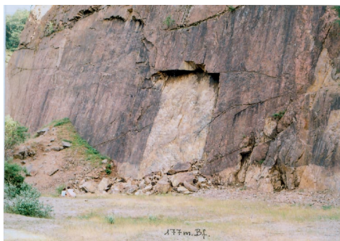
14. ábra Törési síkok mentén létrejött bányafal omlás a 177 m.Bf. művelési szinten Fig. 14. Pit wall collapse at the 177 m.Bf. extracting bench, formed along fracture plains
