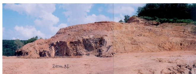
11. ábra Morzsalékos, erősen elbontott gránit, az üde gránit és a fedő gránitmurva között Fig. 11. Fractured, heavily loosened granite layer between the covering granite gravel and the intact granite mass
