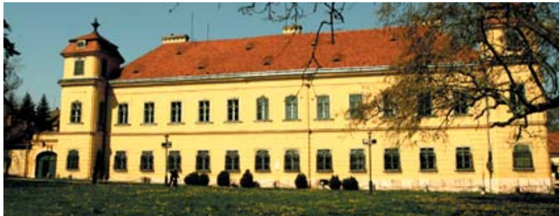
Nagykastély homlokzat a tó felől
