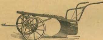
88. ábra. Scholtz vasgerendelys váltárforgató hegyi ekéje.
