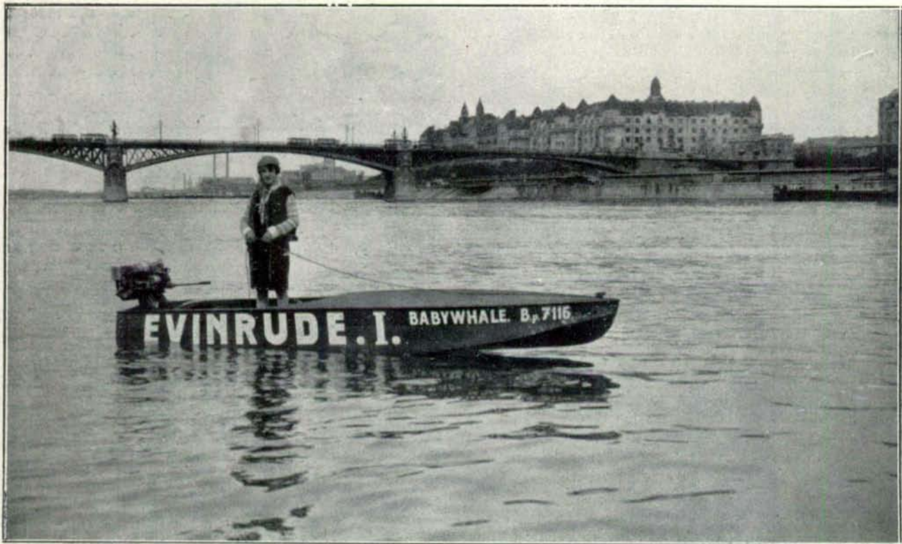
Evinrude-siklóhajó a Duna vizén, Budapesten. Képünk jól mutatja a siklóhajótest stabilitását. Háttérben a Margit-híd.
