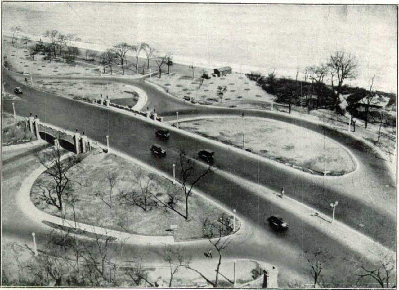
Chicago (USA) egy a Michigan-tó partján épült útja, ahol a mellékutak betorkollása alagutak segítségével történik.
