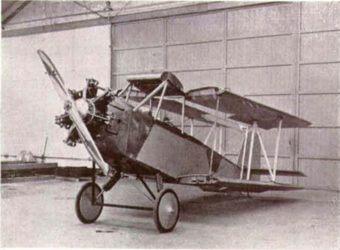
A Bayerische Flugzeugwerke „Typ. M. 21” gépe összehajtható szárnyakkal.
