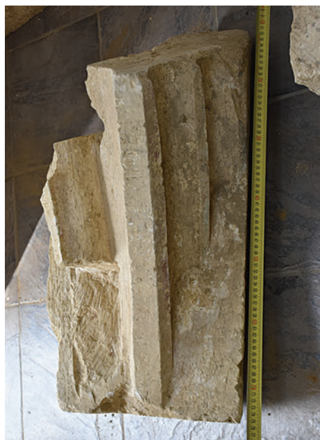
36–37. K7 – bordás keresztboltozat alsó rétegekőve feltehetőleg a szentélyből
