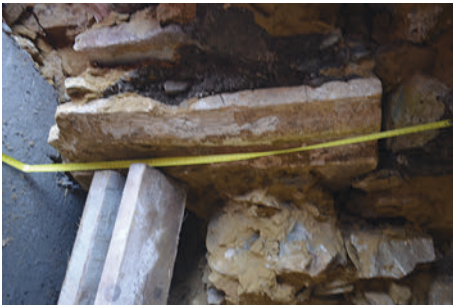
40–41. K9 – egyes bordaindítás a kiemelés előtt és után
