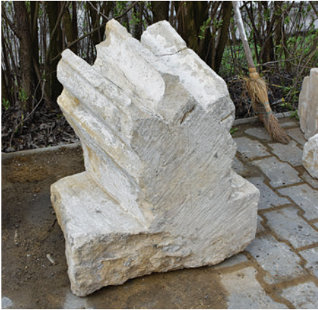
30–31. K4 – hajó gótikus boltozatának réteggőve
