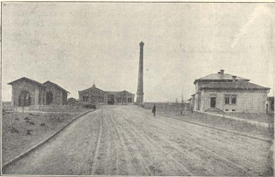
8. ábra. A szivattyútelep.
