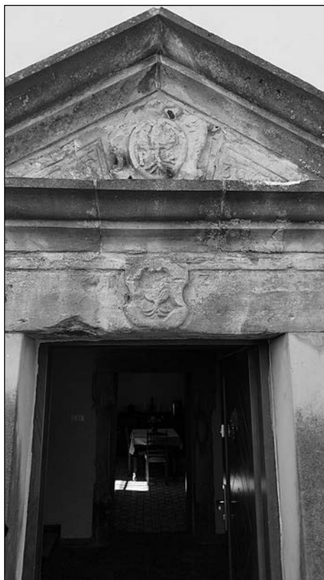
Az ublineki imaház homlokzata
