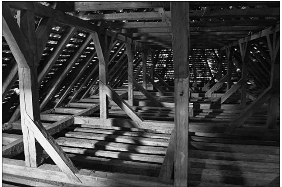
A csekefalvi templom közmunkával kitakarított tetőszerkezete.
