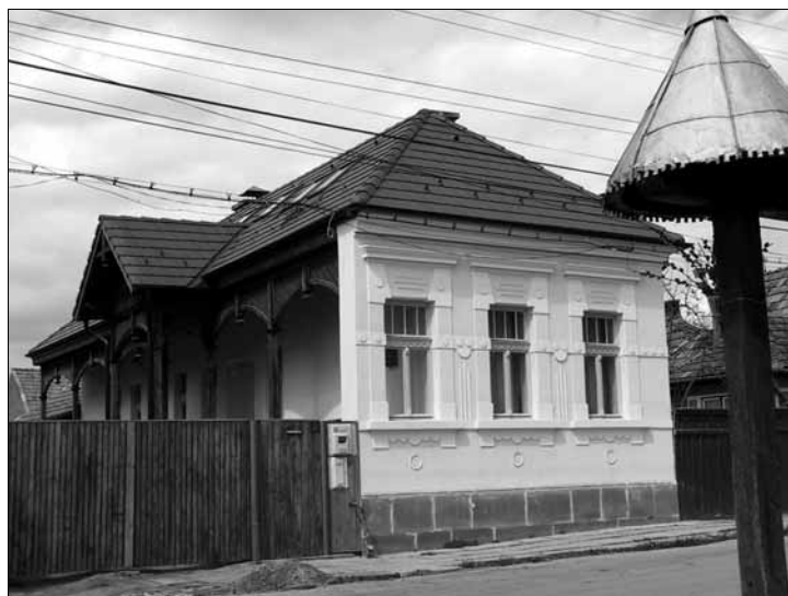
A Csíkzsögödi lakóház felújítása
