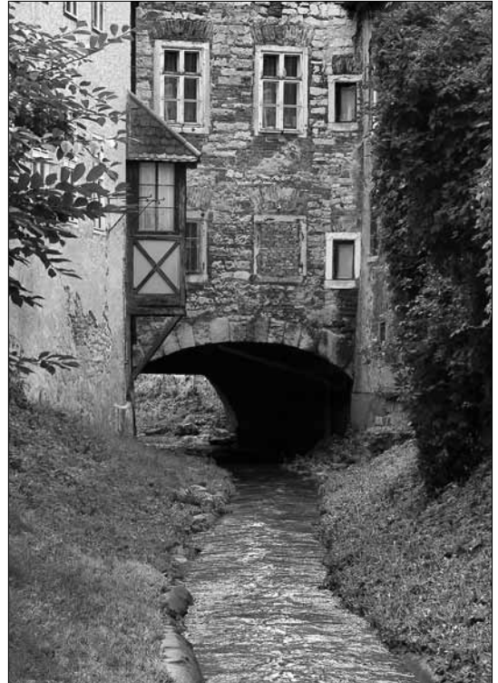
Sopron – Ispotály Híd
