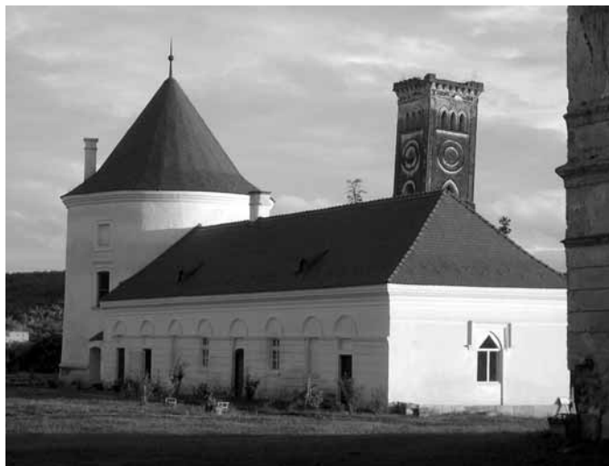
A volt konyhaépület felújítva
