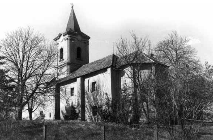
Bakonyzentlászó, evangélikus templom a helyreállítás előtt (foto: KÖH Fotótár)
