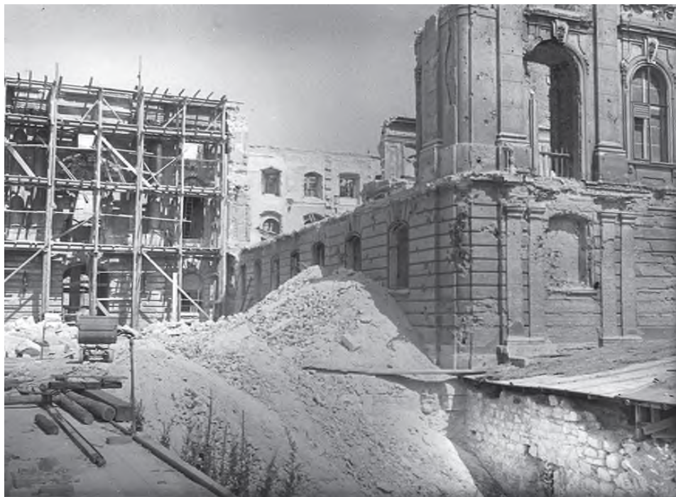
16. A Nyugati zárt udvar visszatöltése az „E” palotatömb bontási törmelékével Rákosi utasítására, 1952. augusztus 19. Molnár János felvétele, BTM VM KFO FT 6234
