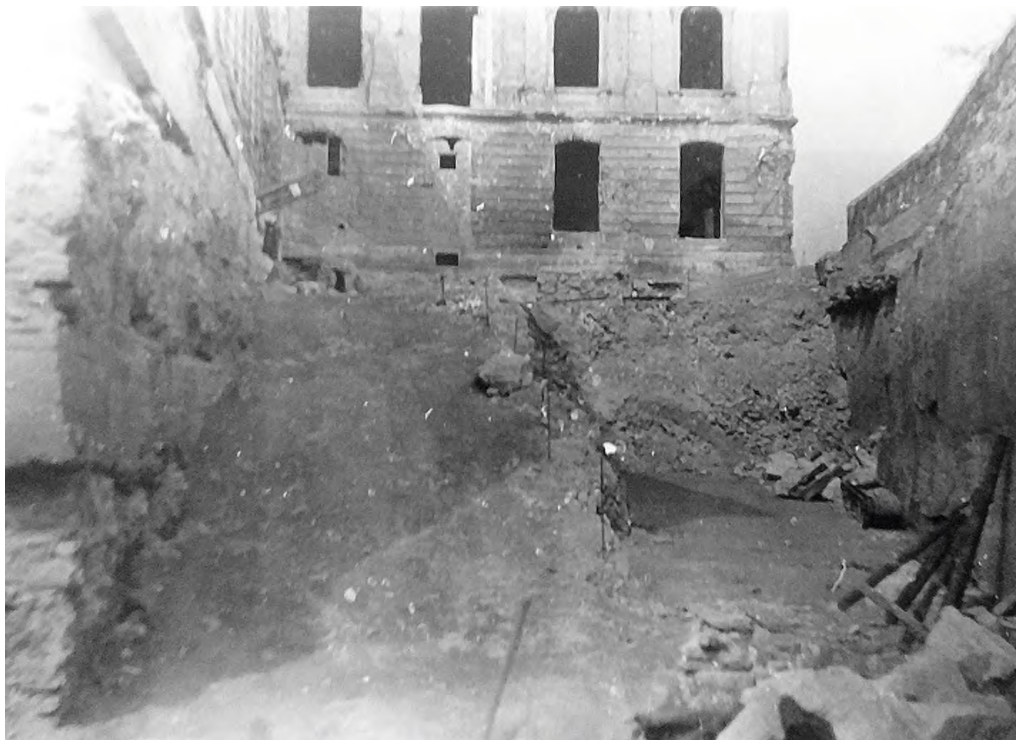
23. A Rákosi által újra feltöltetett keleti udvar kibontás közben, 1965 első hónapjaiban. Gombos 1965, 7. utáni sztl.
