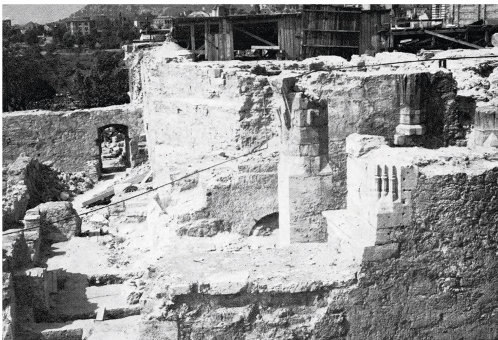
10. A déli udvar feltárása a gótikus nagyterem maradványaival és a télikert még álló alapfalával, 1950. Középen a nyugati várfal déli szakasza a teljes mélységében kibontott középkori szegmensíves kapunyílással (megfigyelhető a kapupántok ma már nem látható helye). Balra egy másik, csak részben kibontott (később visszafalazott) nyílás látható. Az udvar mai szintje mintegy másfél méterrel e feltárt középkori szint fölött van. A felvételt közölte: Gerő 1980, 135
