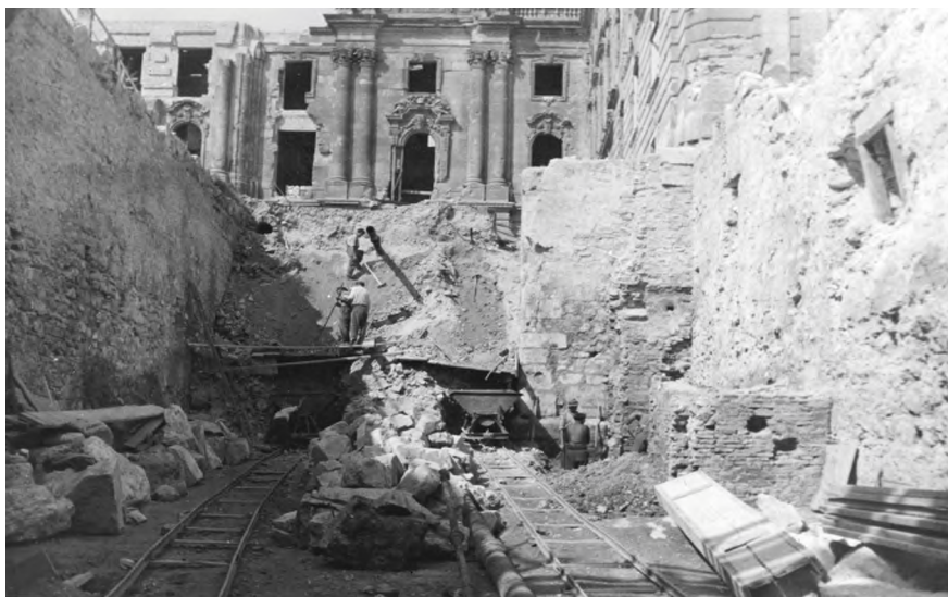
15. A Nyugati zárt udvar szintsüllyesztése a 17–18. századi feltölt(őd)és anyagának elszállításával, 1951. BTM VM KFO FT 2671
