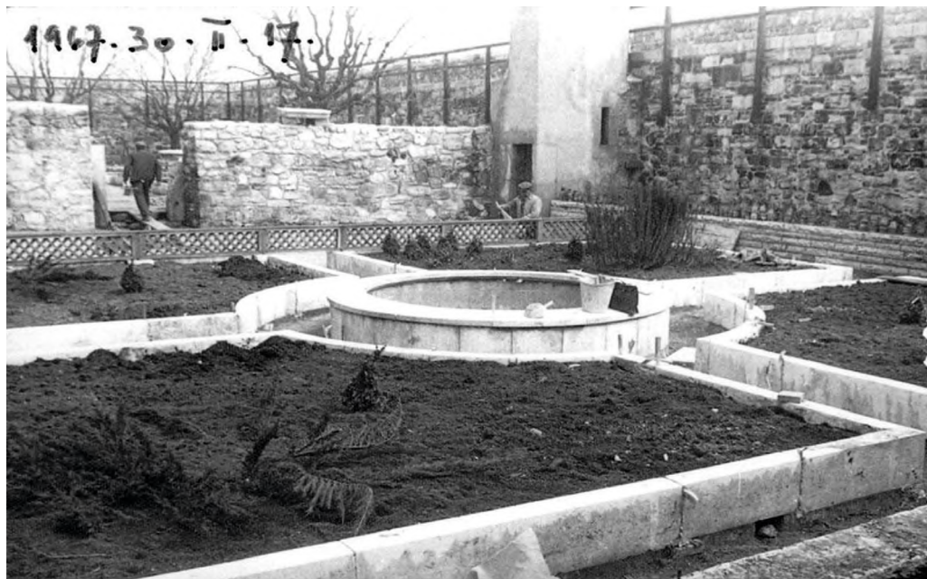
53. A déli zárt kertek építése 1967 februárjában. Az ágyások és a szökőkút mészkő-elemei még fugázásra várnak, és a növényültetés folyik, a kavicsburkolat még hiányzik. A táblákban már beültetett nehézszagú boróka és egy-egy (később átültetett) kúp alakú puszpáng. Az egyik munkás éppen a tervet tanulmányozza. (FŐKERT, zoldkalauz.hu)
