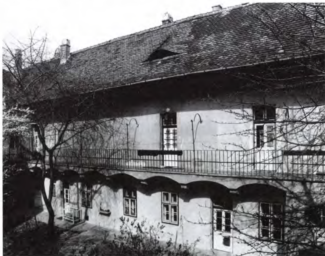
19. kép. A Váralja utcai épületszárny az udvar felől.
