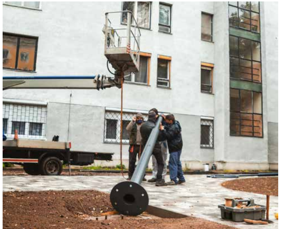
A képen a napelemes térfigyelő kamera oszlopa látható
