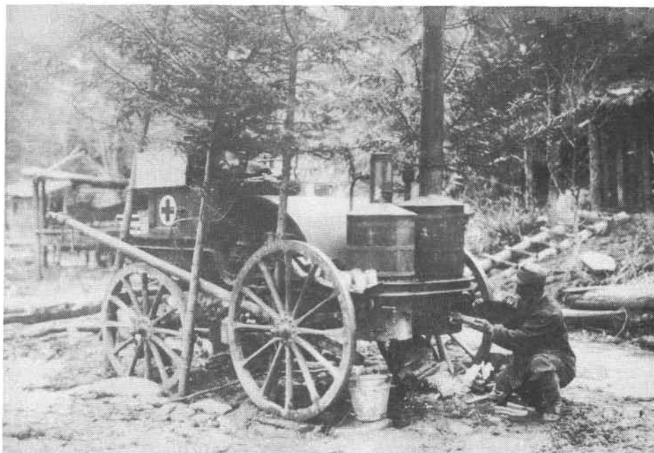
9. kép. Vízesztilláló készülék
