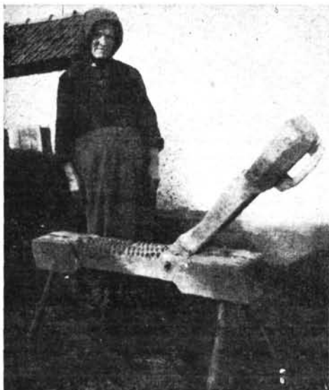
4. kép. Áttört szerkezetű, fogazott élű tiló, Tiszakarád
