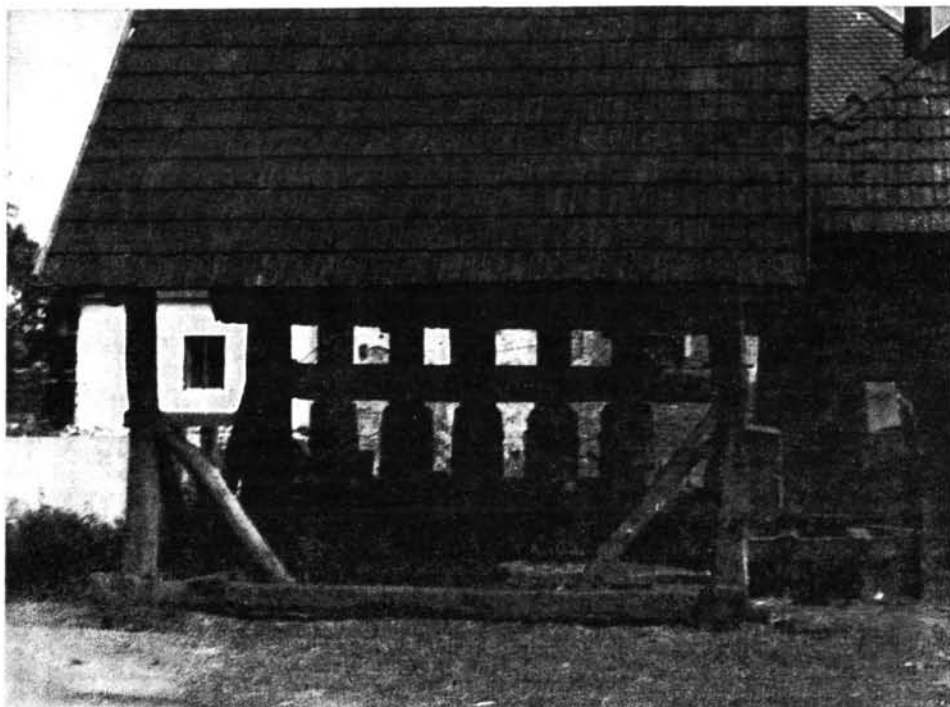
12. kép. Bunkós vagy bakós, nyilas szerkezetű kendertörő malom, Mezőkeresztes
