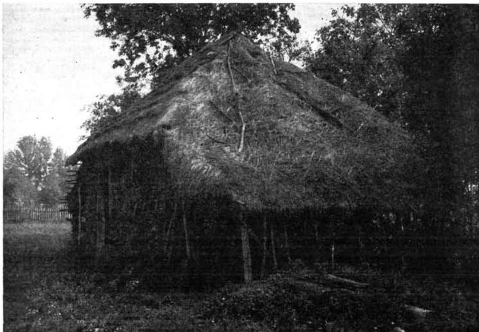
3. kép. Zsúptetős, fonott falazattal és kapuval épült rakodó. Keresztéte, Paládi-Kovács A. felv. 1969
