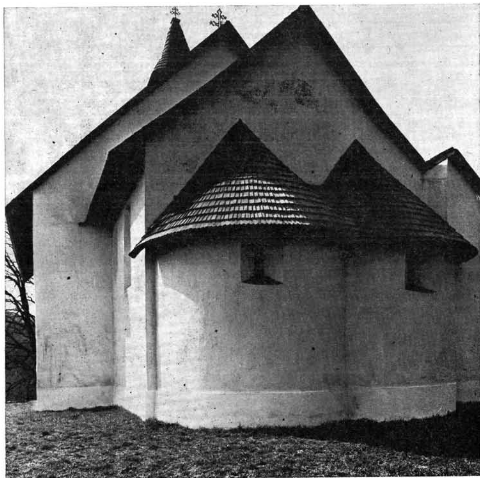
2. kép. A kettős szentély helyreállítás után
