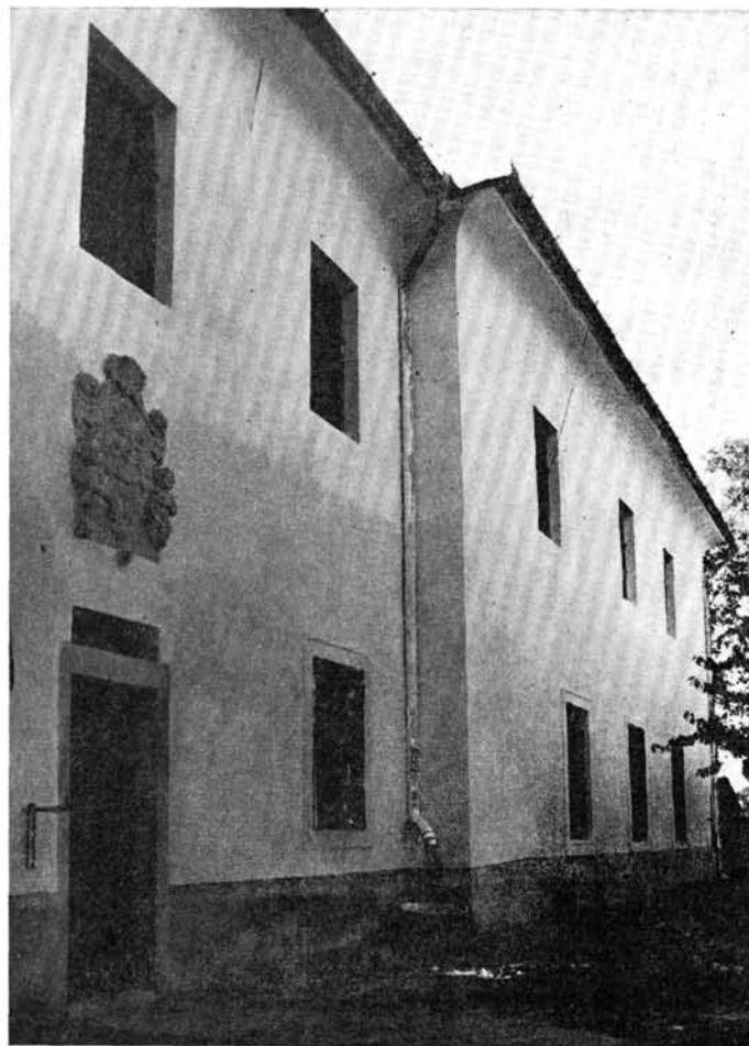
6. kép. Az épület keleti szárnyának kiugró része
