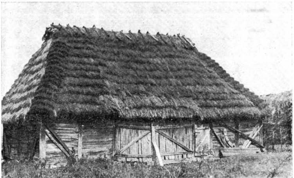
6. kép. Hagyományos szerkesztésű gerendavázás csűr ravásfallal és leppentővel. Mogyoróska, Abaúj m. Szabadfalvi József felv.
