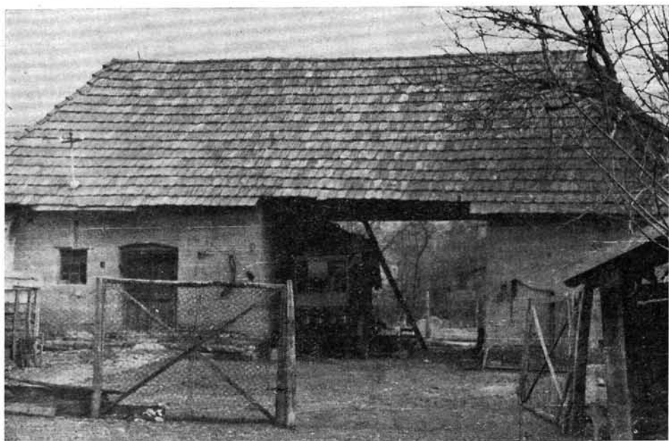
10. kép. Vályogból épített istálló csűr. Parád, Heves m. Selmeczi Kovács Attila felv.
