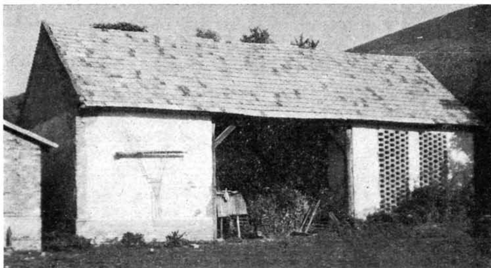
14. kép. Rácsosított téglafalú csűr. Susa, Borsod m. Selmeczi Kovács Attila felv.
