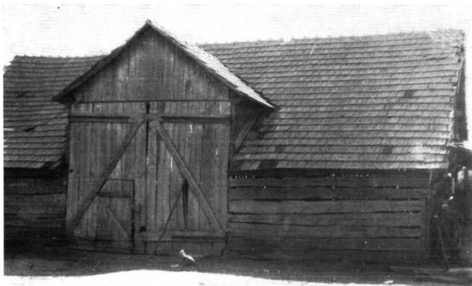
7. kép. Deszkafallal borított gerendavázás torkos csűr. Felsőnyárad. Selmeczi Kovács Attila felv.
