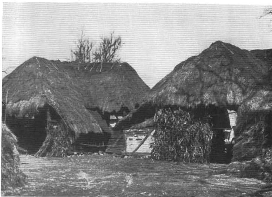
1. kép. Hagyományos szerkesztésű gerendavázás torkos csűrök. Bolyok. Paládi-Kovács Attila felv.
