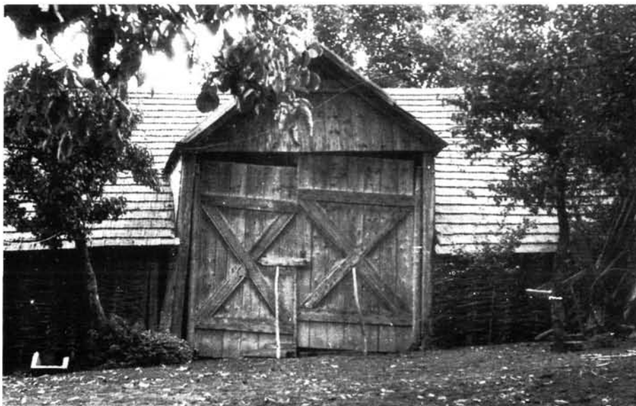
8. kép. Gerendavázás torkos csűr vesszőfallal. Hangács. Bodó Sándor felv.
