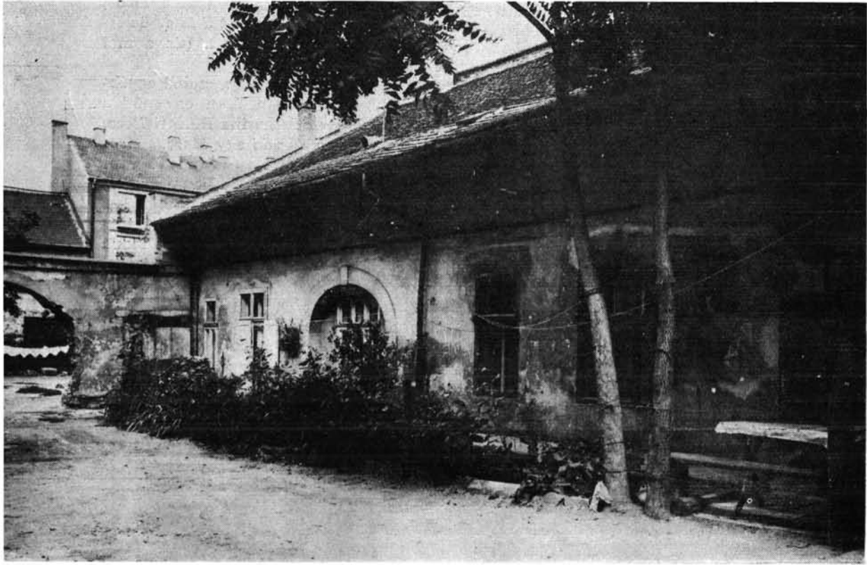
A Pataky-ház telkének keleti oldalán, az északon végződő Döry László-féle épületszárny, a szomszédos keleti telekre átvezető kapujáráttal. A főutcai szalagtelkeknek felaprózódási folyamatában — a telkek északi részében — ez a kapu arra enged következtetni, hogy egyidőben szolgálmi joggal bíró átjárás, kereskedelmi forgalmi célokat is szolgált, társzekerek, málhás kocsik számára
