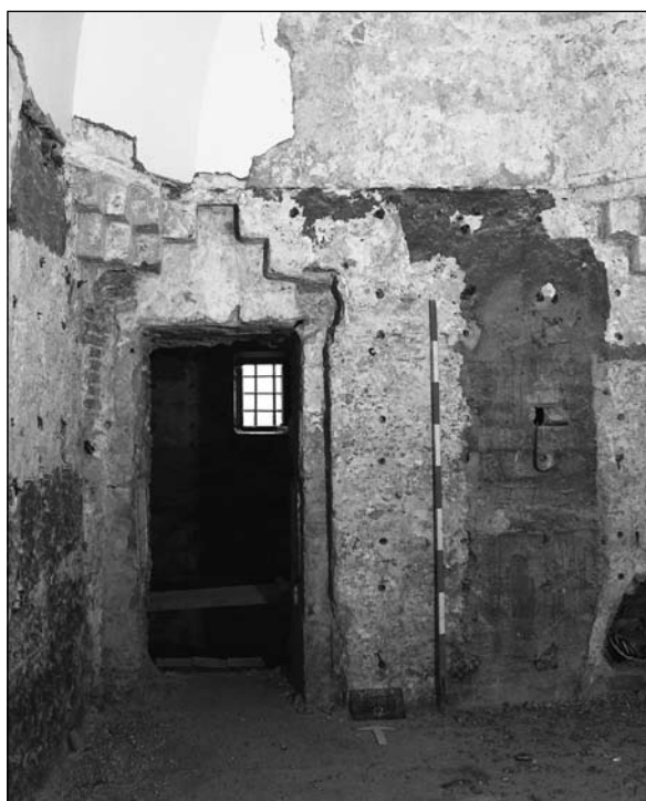
22. kép. Császár fürdő. A forró helyiség és az északkeleti sarokhelyiség közti kibontott török kori ajtó déli oldala.
