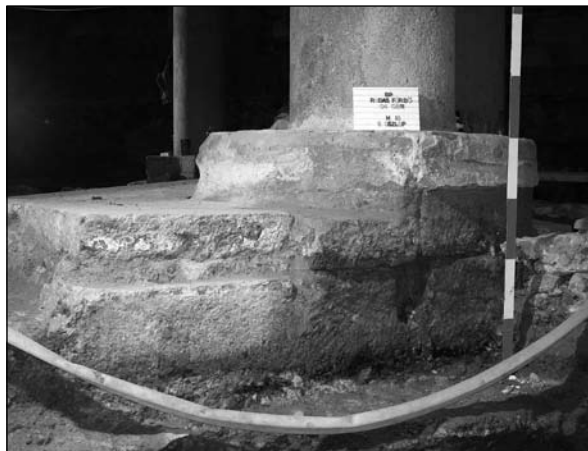
35. kép. Rudas fürdő. Forró helyiség 8-as oszlopának környezete: a medence szerkezetet övező kváderkögyűri részlete az oszlop lábazatával és bal oldalt az in situ török kori padlóval.
