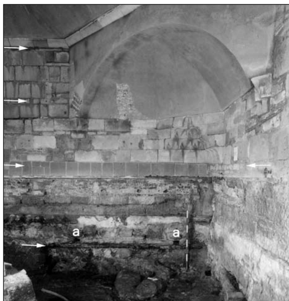
10. kép. Rudas fürdő. Forró helyiség. Nyilakkal jelölve a vízszintes gerendák, „a” betűvel a kereszt elemek.
