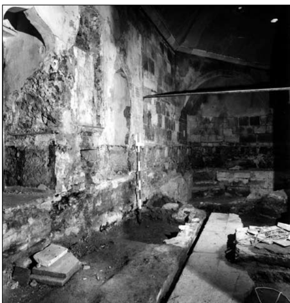
36. kép. Rudas fürdő. Forró helyiségben feltárt török kori padló, a falak mentén húzódó padka alapozásának maradványa és a kettő között húzódó folyóca.
