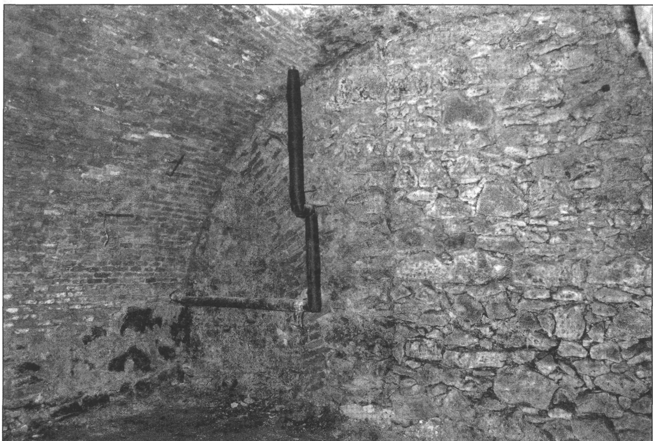
8. kép. Az Országház utca 16. sz. ház pincéje. A pincelejáró melletti kis helyiség keleti oldala, az első helyiség északi falának visszabontott maradványával és a második helyiség boltozatának lenyomatával.
