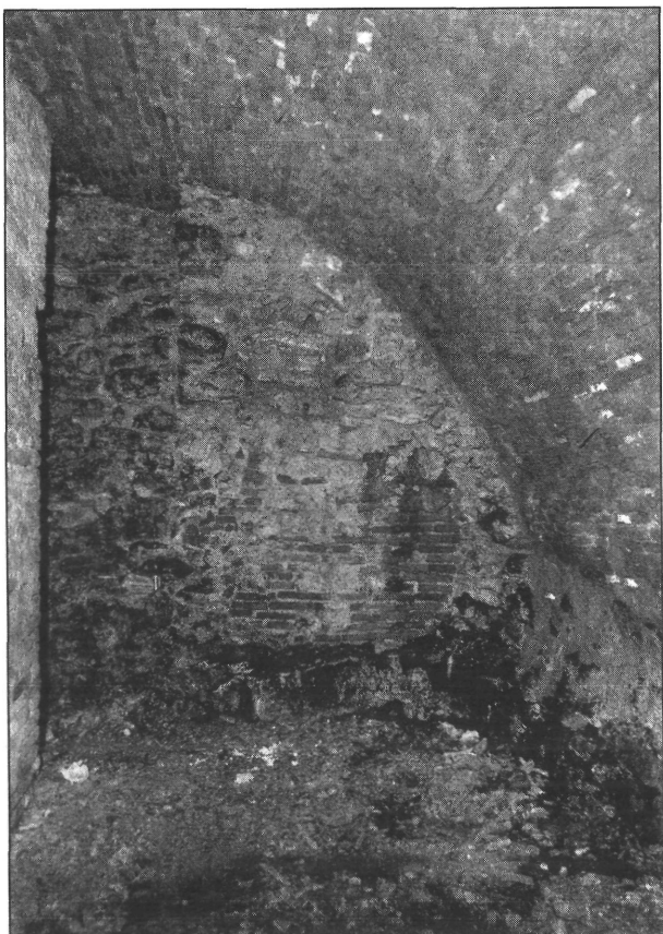
7. kép. Az Országház utca 16. A pincelejárát melletti kis helyiség nyugati fala, a visszabontott középkori falmaradvánnyal.
