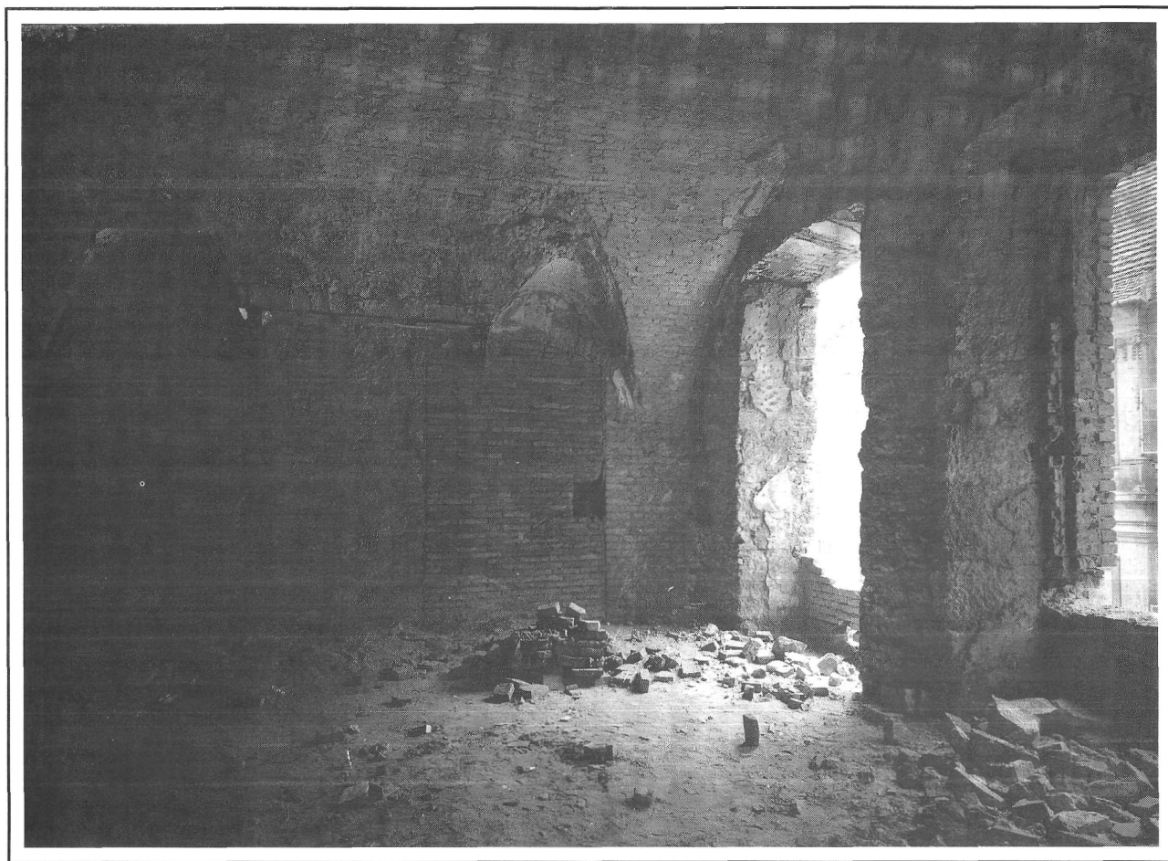
20. kép. Az utcai menet emeleti, déli szélső helyiségének barokk boltozata a boltozatfiókot leszűkítő falazásokkal és vállkiváltással. Nézet dél felé. 1959. évi állapot.
