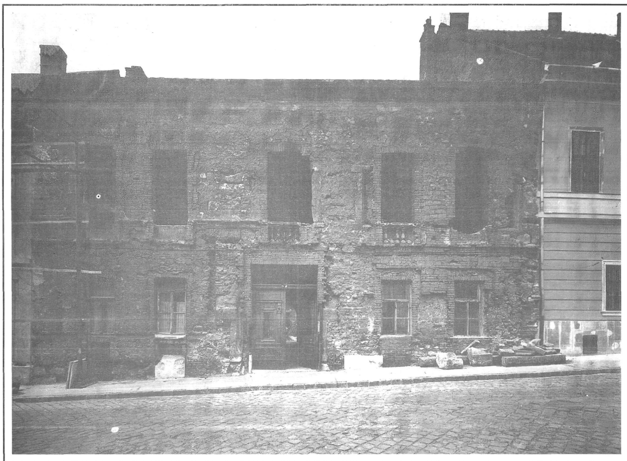
5. kép. Utcai homlokzat a feltárások megindítása előtt 1957-ben. Abb. 5. Straßenfront vor Beginn der Erschließungen i.J. 1957.
