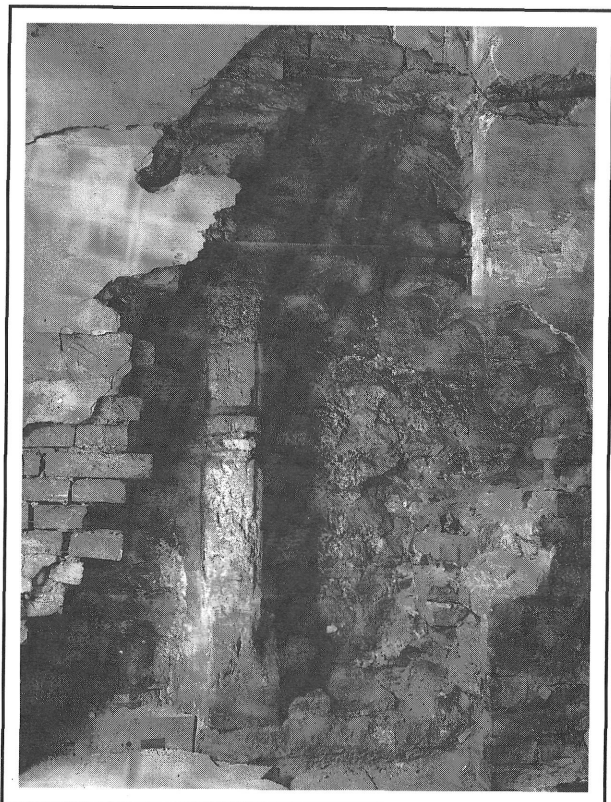
11. kép. A kapualj északi falának nyugati szélén lévő ülőfülke. 1959. évi állapot: az eklektikus téglaköpenyfal mögült történt kibontás.
